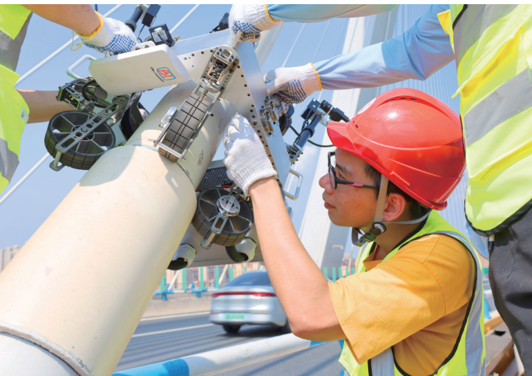
马桑溪大桥，检测人员利用爬索机器人进行拉索外观检查
