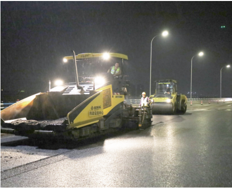
嘉悦大桥蔡家侧桥台路面整治
