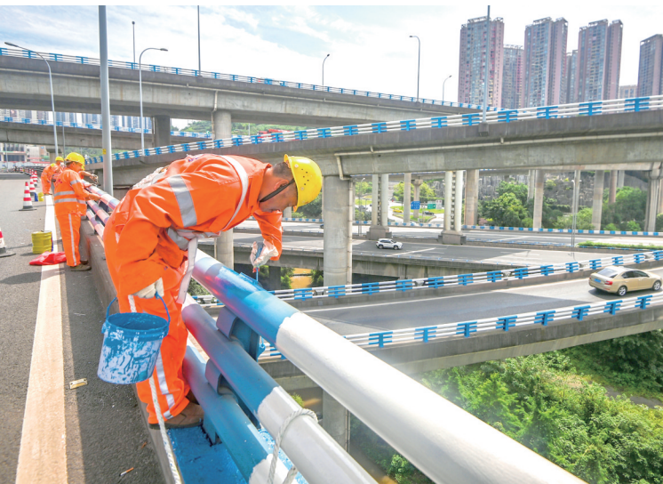
黄桷湾立交，涂装人员对防撞护栏进行涂装维护
