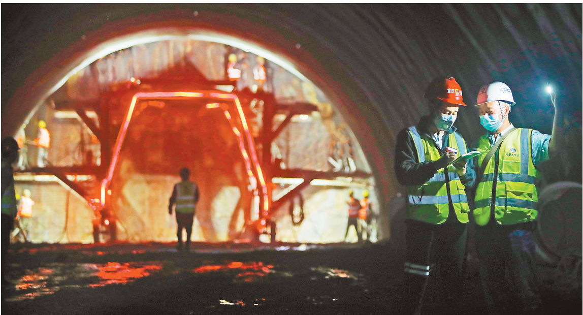
九月十四日，巫云开高速朝阳隧道内，技术人员正在记录掘进数据。 记者 罗斌 摄影视觉重庆
