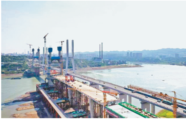
轨道18号线建设现场
