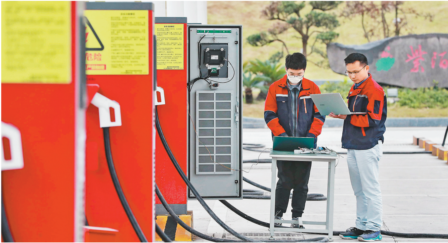
重庆高新院的科技人员在调试新型碳化硅半导体充电桩。(摄于二〇二一年二月十八日) 特约摄影 谢捷 视觉重庆
