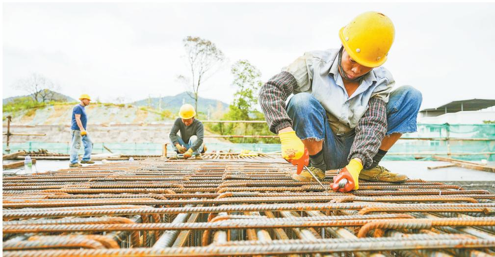
8月31日,巴南区渝南大道D段南段项目二期工程现场,工人正在捆绑钢筋。
