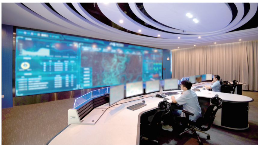
重庆中法供水公司悦来水厂全景数字智慧中心
