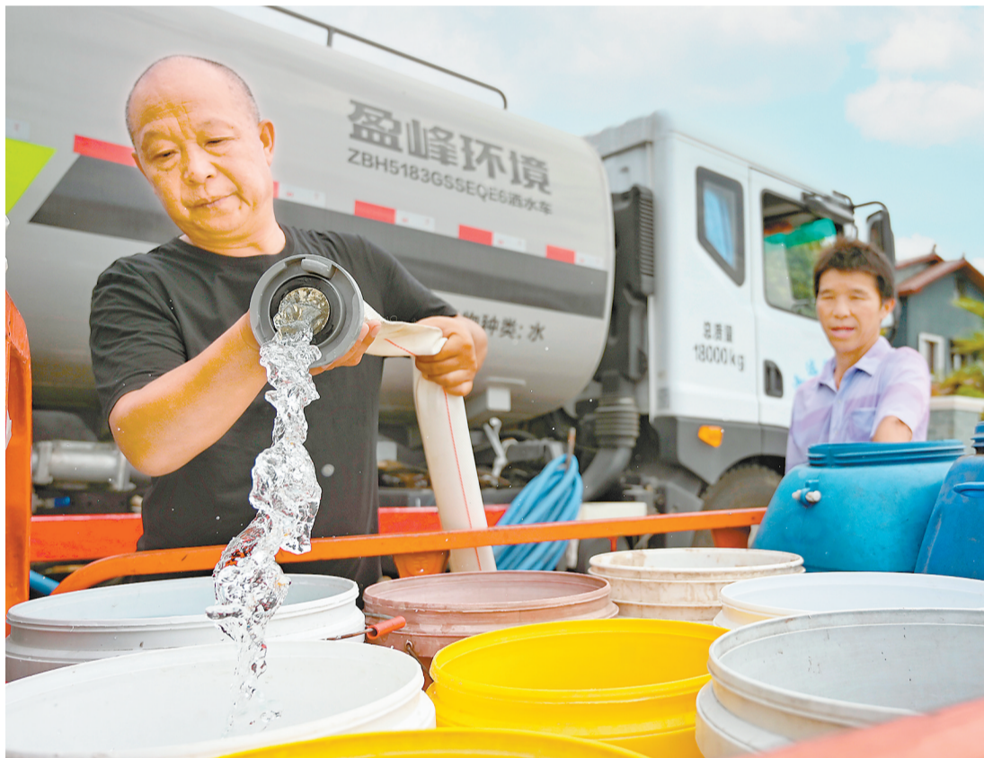
▲8月26日，万州区恒合土家族乡八一村，村民在安装农田灌溉应急专用水管。 特约摄影 冉孟军 摄/视觉重庆
