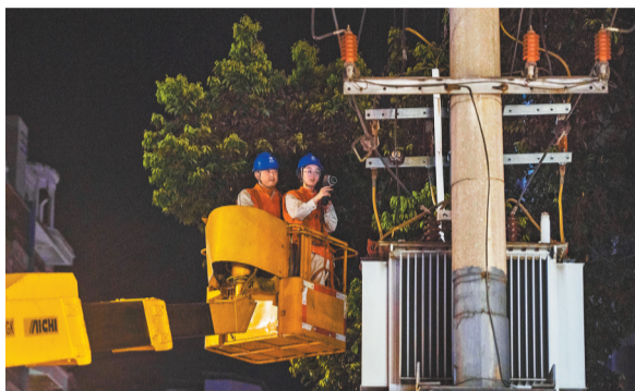
8月10日晚,璧山区金剑路,国网璧山供电公司现场作业班正对电力设备进行测温和维护。 记者 齐岚森 实习生 周宇飞 摄/视觉重庆
