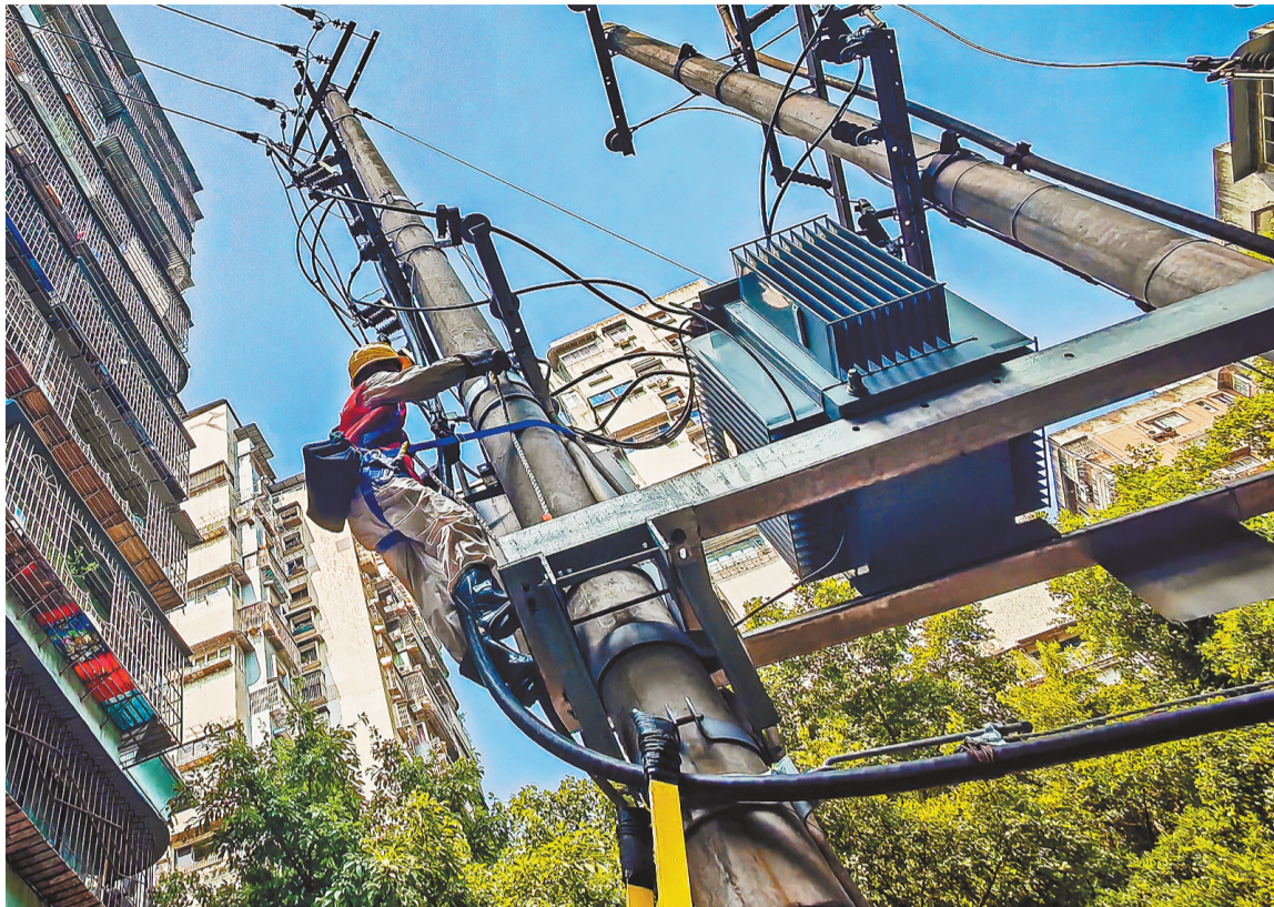
8月16日,渝中区华福巷社区,国家电网红岩(市区渝中)共产党员服务队队员们正在对老旧小区的变压器进行测温 and 测负荷。 首席记者 龙帆 实习生 尹诗语 摄/视觉重庆
