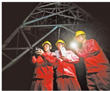
▲8月18日晚,国网彭水供电公司输电运检班工作人员用红外线测温仪对输电线路及设备测温,确保电力供应。
