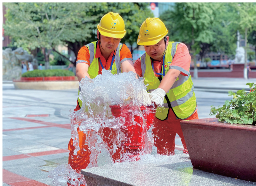
管道维护人员在检查市政消防栓
