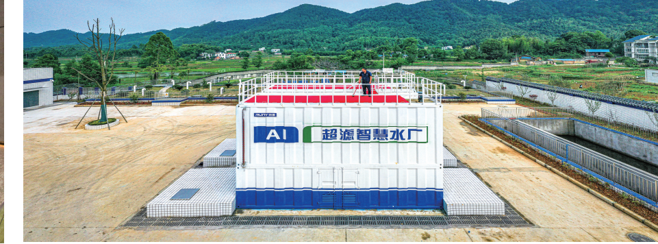
首个“AI超跑智慧水厂”新店水厂正式建成投用
