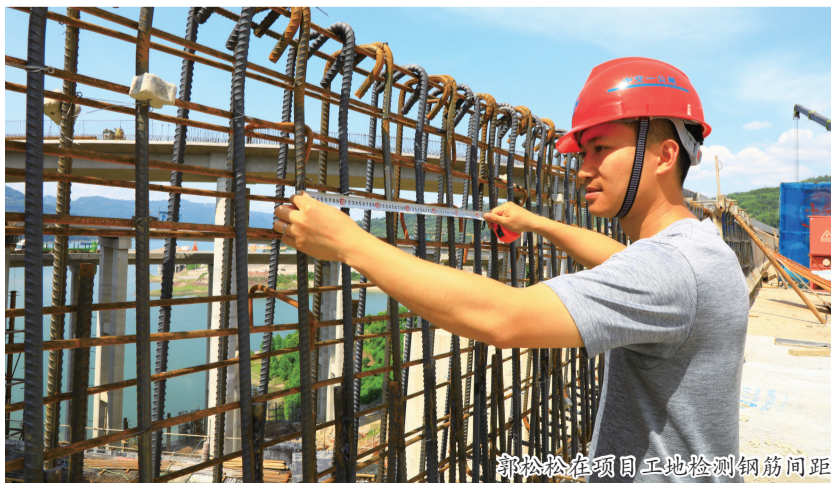
郭松松在项目工地检测钢筋间距
