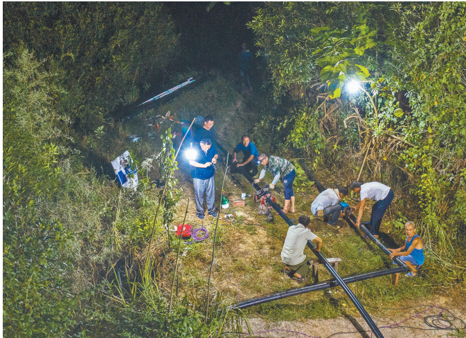
▲8月16日,巴南区南泉街道龙井村,工人正在连夜施工,加紧建设供水管道。记者 郑宇 实习生 尹诗语 摄/视觉重庆
