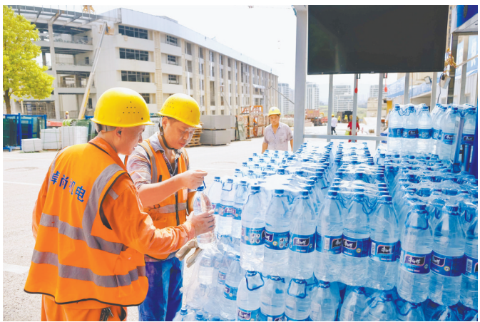
▲8月15日,南岸区广阳湾智创生态城通江新城中学项目现场,施工人员在项目部补水点领取瓶装饮用水。特约摄影 郭旭/视觉重庆
