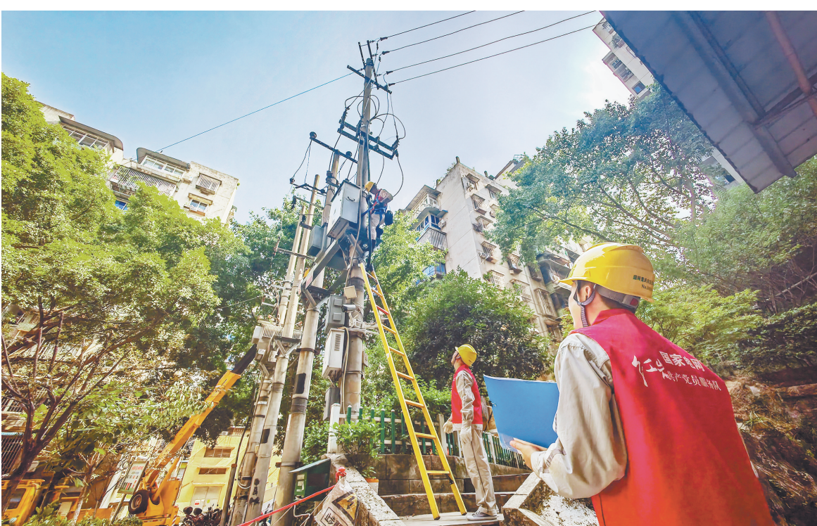
八月十六日,渝中区华福巷社区,国家电网红岩共产党员服务队为老旧小区更换变压器和测负荷。 首席记者 龙帆 实习生 尹诗语 摄 视觉重庆
