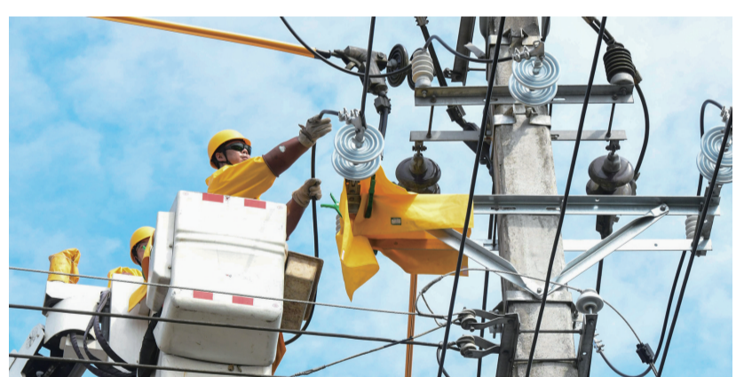
国网合川供电公司员工烈日下在10千伏青利线进行带电搭火作业 摄/邓皓天
