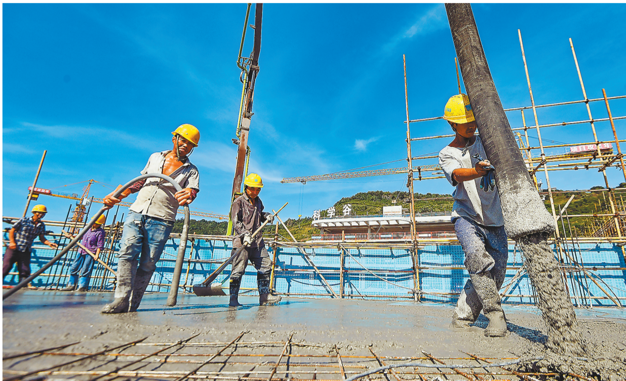
8月10日，西部(重庆)科学城科学谷一期，中建七局的工人们正在浇筑混凝土。
