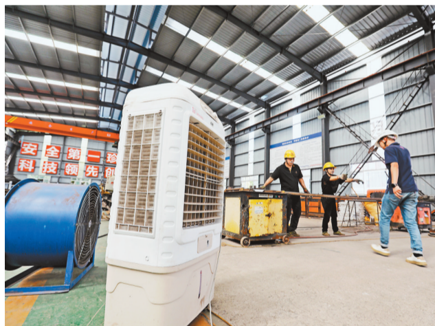
8月10日上午,在建的轨道交通18号线李家沱长江复线桥施工现场,多台空调和风机为工人降温。记者 罗斌 摄/视觉重庆
