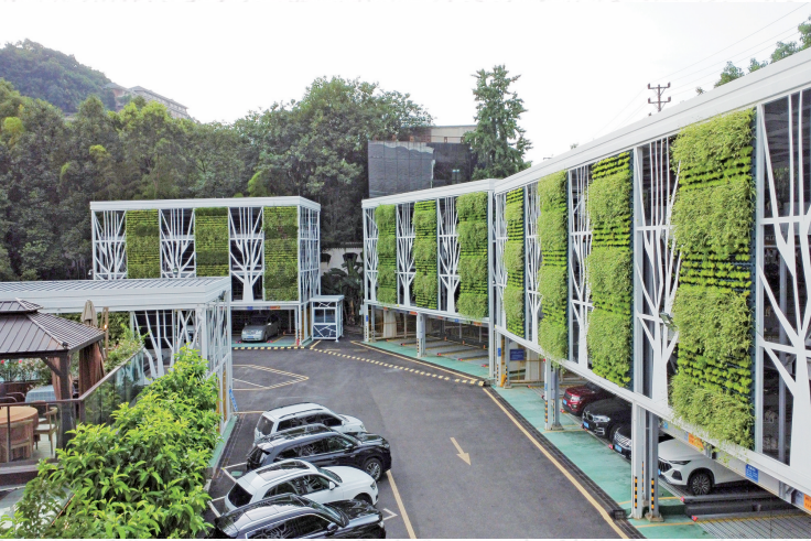
南岸区崇文路口新修建的机械停车场
