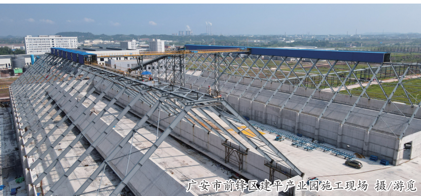
广安市前锋区建平产业园施工现场 摄/游觅
