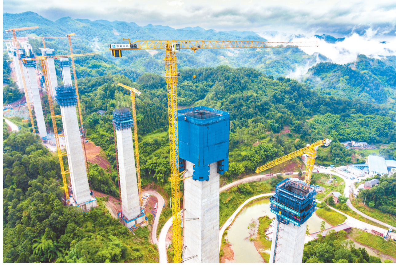
8月2日，位于巴南区的渝湘复线高速公路芦沟河特大桥正加紧施工。
