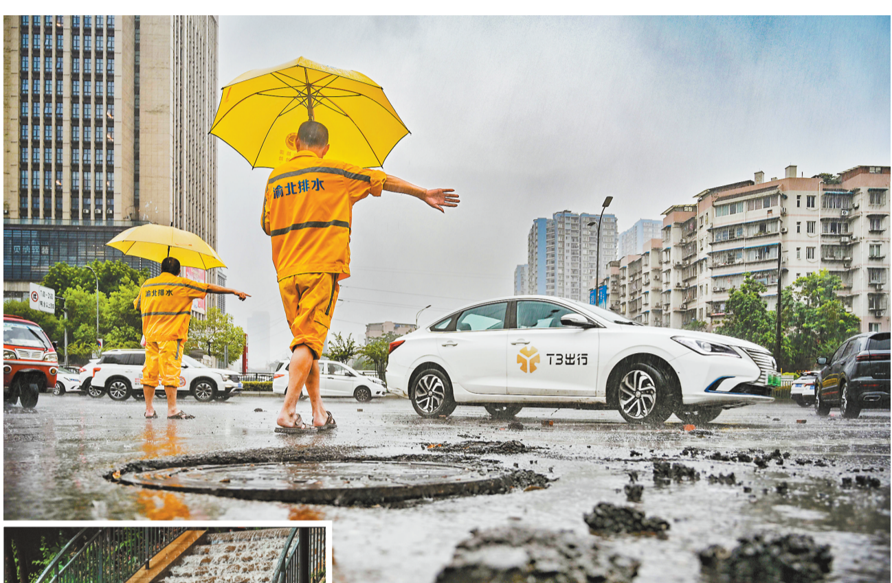
▲7月18日,渝北区旗山路与松石大道交界处,井盖被雨水顶开发生松动,周围路面发生损坏,抢险人员在此提醒过往车辆避让。
