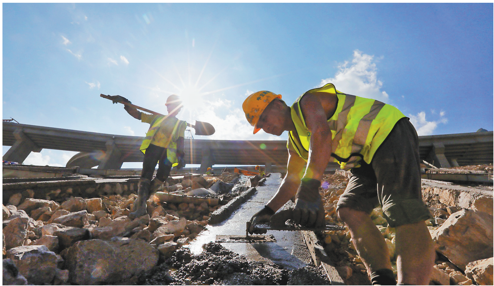
▲7月10日,城开高速李子互通,中国交建的建设者避开高温,采取错峰、轮岗等方式施工。记者 罗斌 摄/视觉重庆
