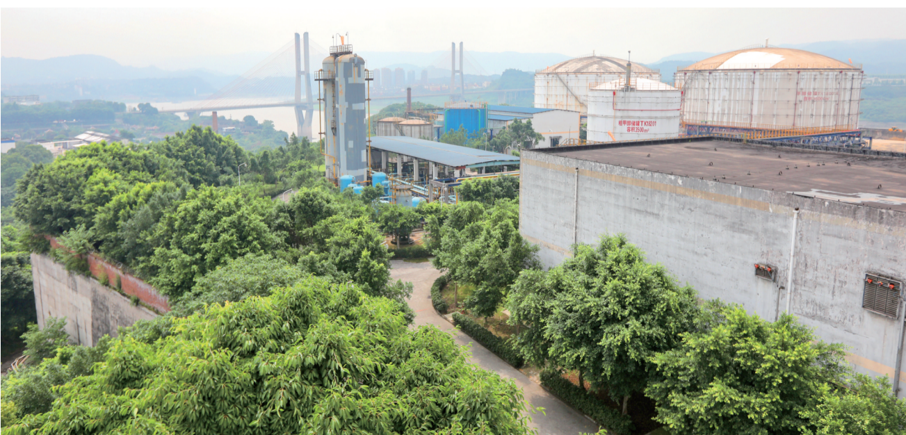
粗甲醇装置罐区
