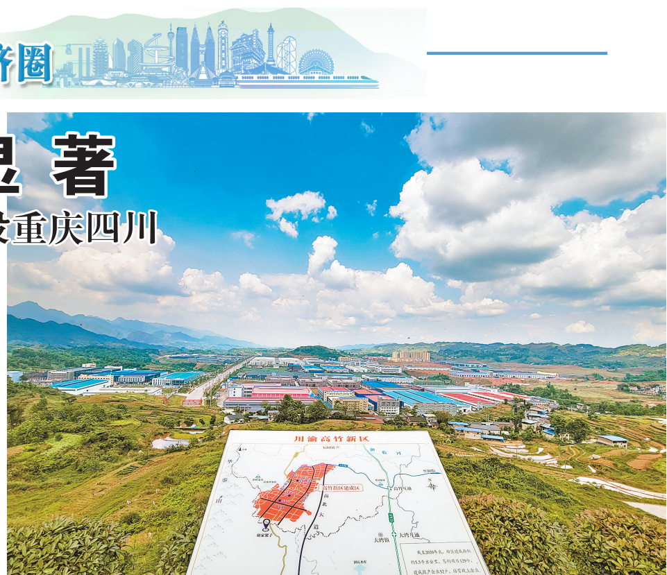
建设中的川渝高新新区。(资料图片)
