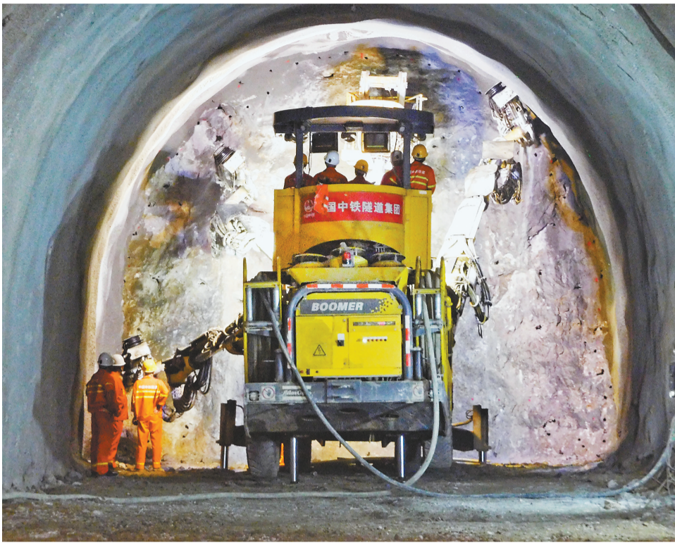
郑渝高铁小三峡隧道辅助坑道凿岩台车施工。(摄于2017年5月18日) 成都铁路局供图
