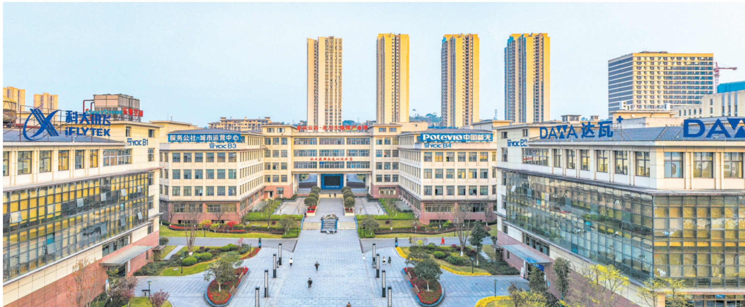
重庆云谷·永川大数据产业园 摄/陈科儒
