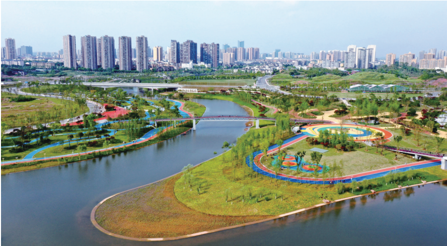
涪江铜梁城区防洪护岸综合整治工程
