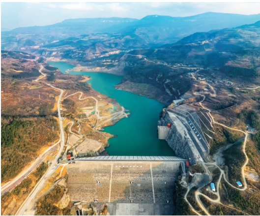
南川金佛山水库下闸蓄水
