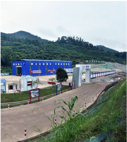
渝西水资源配置工程永川永安隧洞工程施工现场
