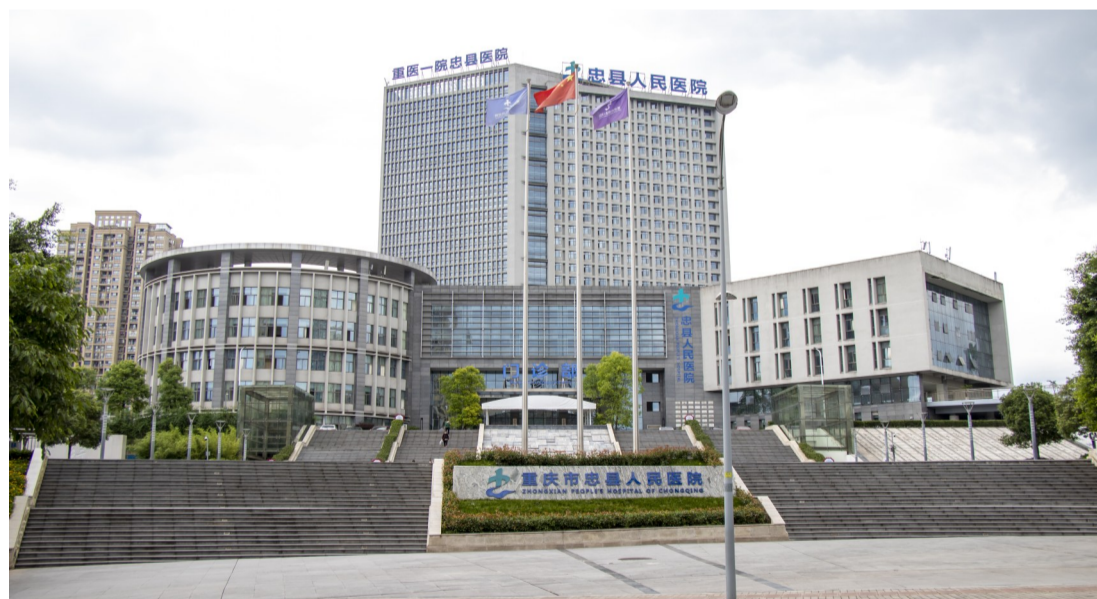
山东省援建的鲁忠医技大楼
