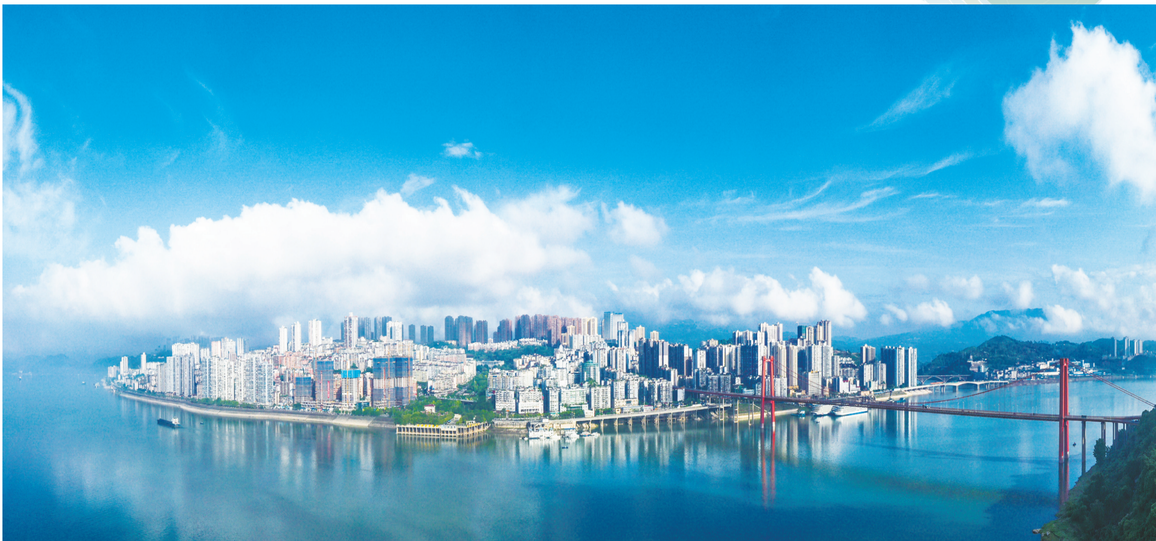
山东省和沈阳市援建的忠县长江大桥
