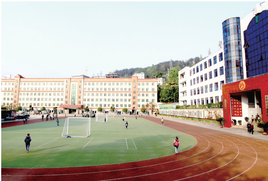
江西省、云南省援建武隆区实验小学教育基础设施
