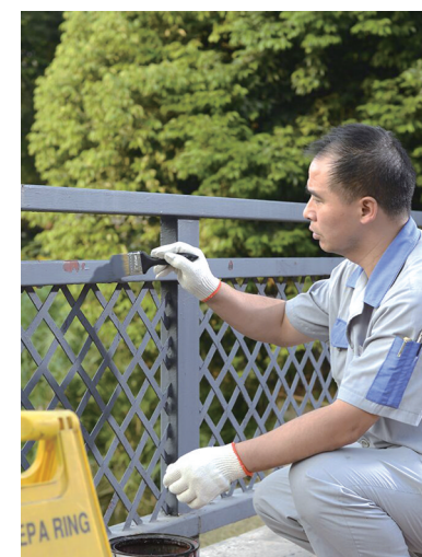
物业人员进行小区设施焕新
