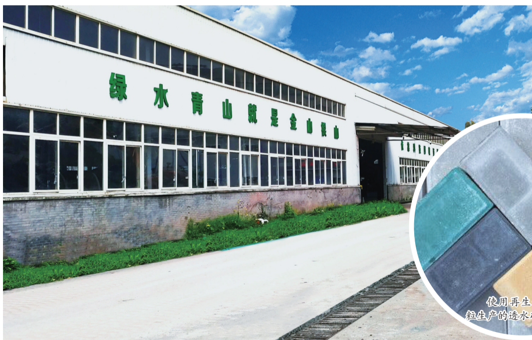
谊辉鸿公司位于两江新区的建筑垃圾资源化转化基地
