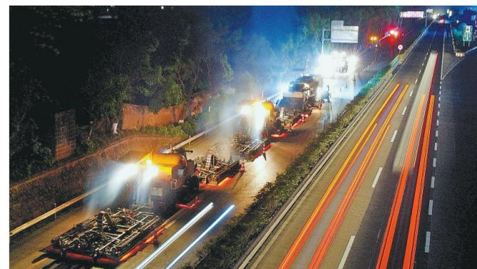
4月21日凌晨,成渝高速白市驿段,重庆高速集团通力公司工程人员正通过“再生列车”修复路面。由于成渝高速车流量大,为最大程度减小占道施工对交通的影响,重庆高速集团成渝高速就地热再生路面预防性养护工程采取全夜间施工模式,预计月底全部完工。
