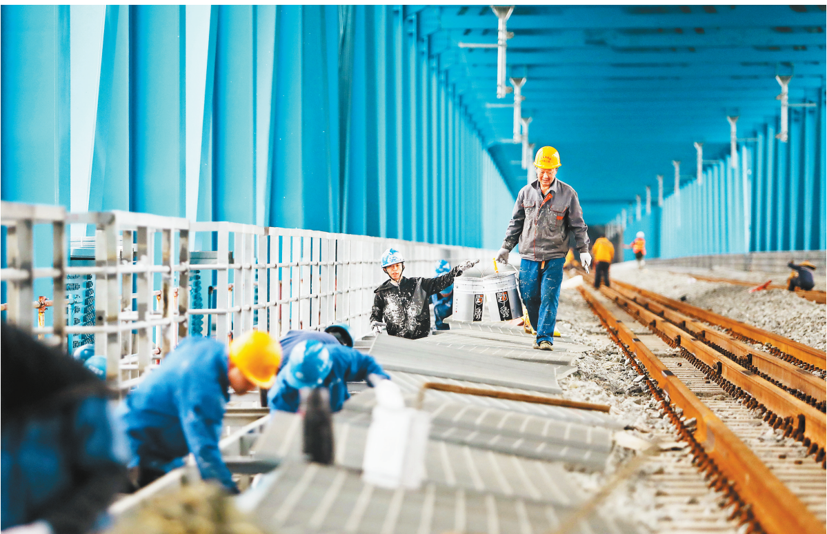
四月十五日,铁路枢纽东环线明月峡长江大桥,工人正在安装护轨和防抛网。
