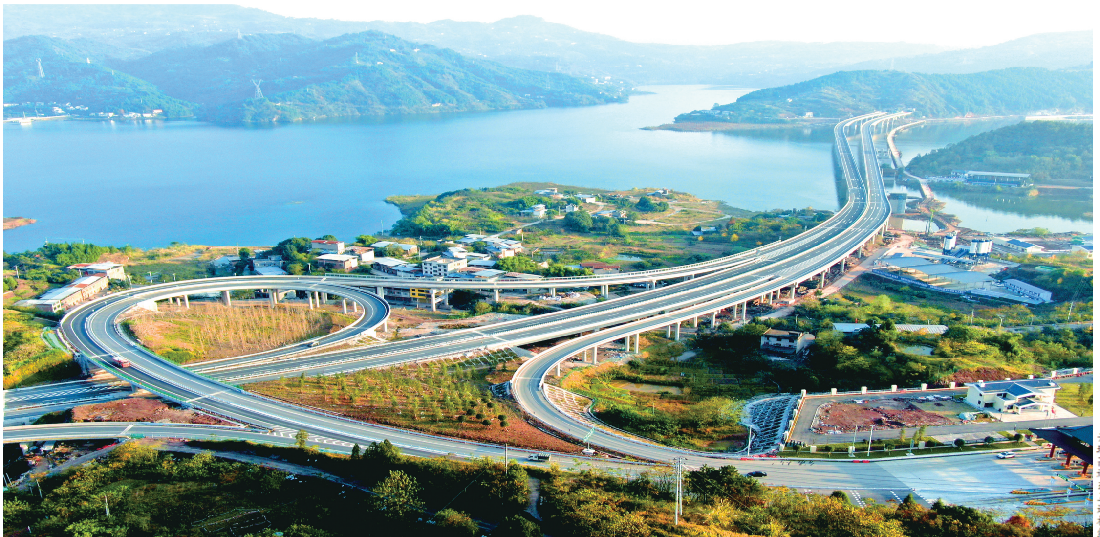
开州高速东互通枢纽
