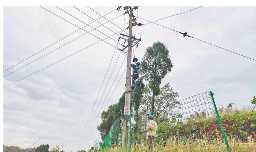
▲受大风影响,铜梁多处电力供应中断,电力工人正在抢修电力设施。 通讯员 李慧敏 摄/视觉重庆
