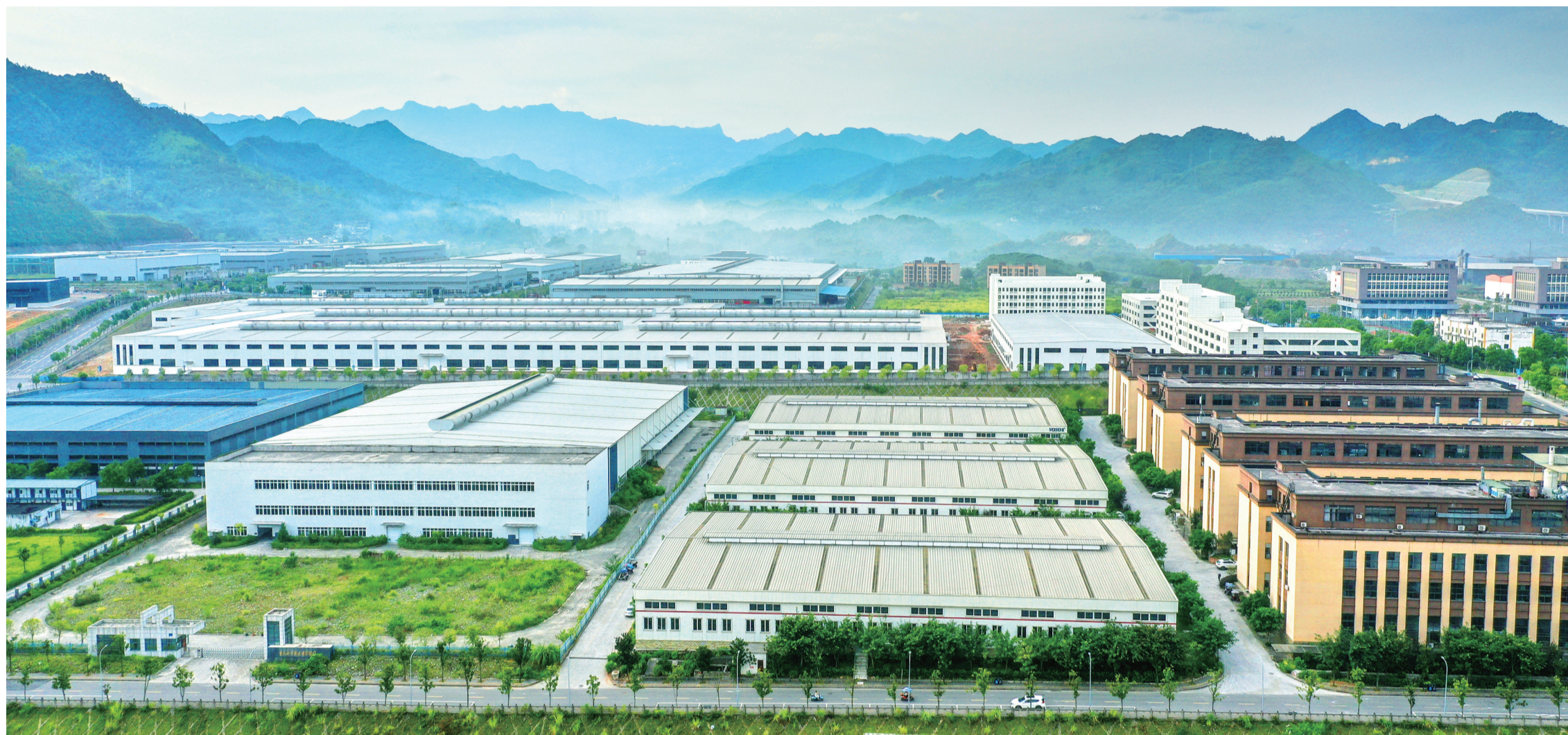
平山产业园区里一座座标准厂房拔地而起 摄/尹南源
