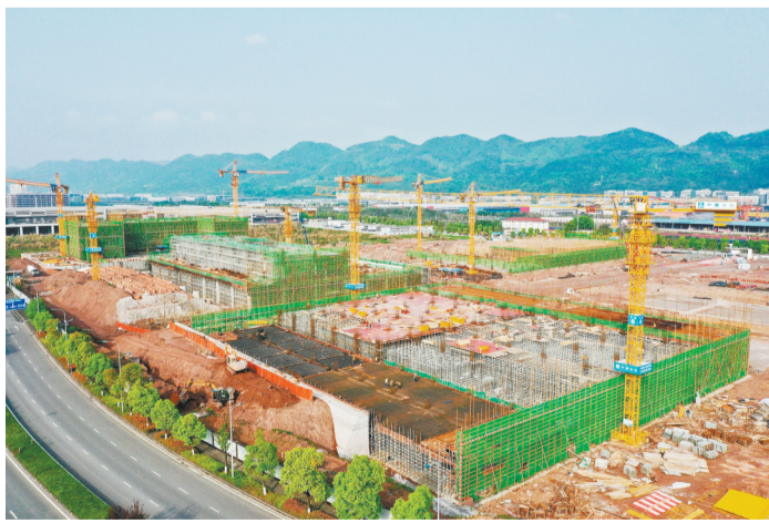
▲陆海新通道重庆无水港正在进行主体施工。
