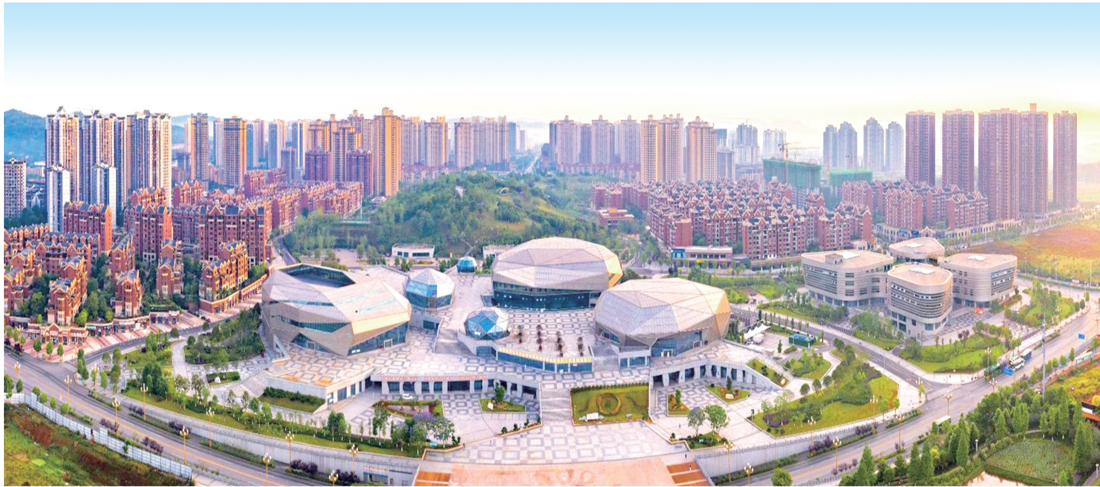
大足区文化馆、图书馆、城市综合展示馆鸟瞰图 摄/罗国家
