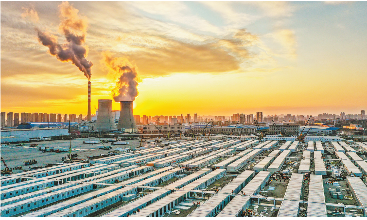
这是三月二十日傍晚拍摄的吉林市高新区隔离方舱建设现场(无人机照片)。新华社记者张楠摄
