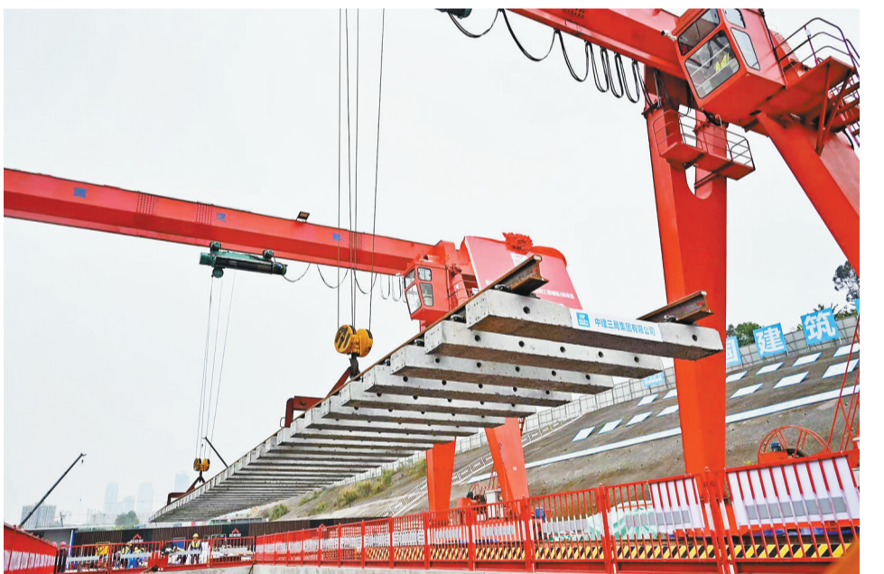
地铁5号线北延伸段年底通车 3月25日上午，渝北区中央公园在建的甘悦大道地铁站附近，随着铺轨机将首根长25米、重14吨的轨排稳稳地落在轨道上，标志着地铁5号线北延伸段正式进入铺轨施工阶段，全线有望年底建成通车。地铁5号线北延伸段工程线路全长8.64公里，线路起点接5号线一期工程园博中心站，止于悦来北路站，设车站7座。 文/记者杨永芹 图/中建隧道提供
