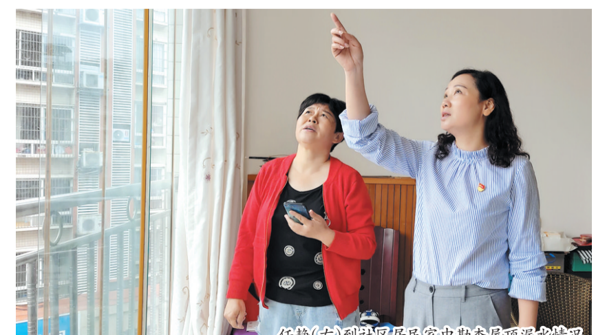
任静(右)到社区居民家中勘查屋顶漏水情况
