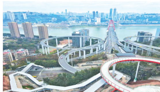
铜元局苏家坝步道观景平台主体完工 摄/郭旭
