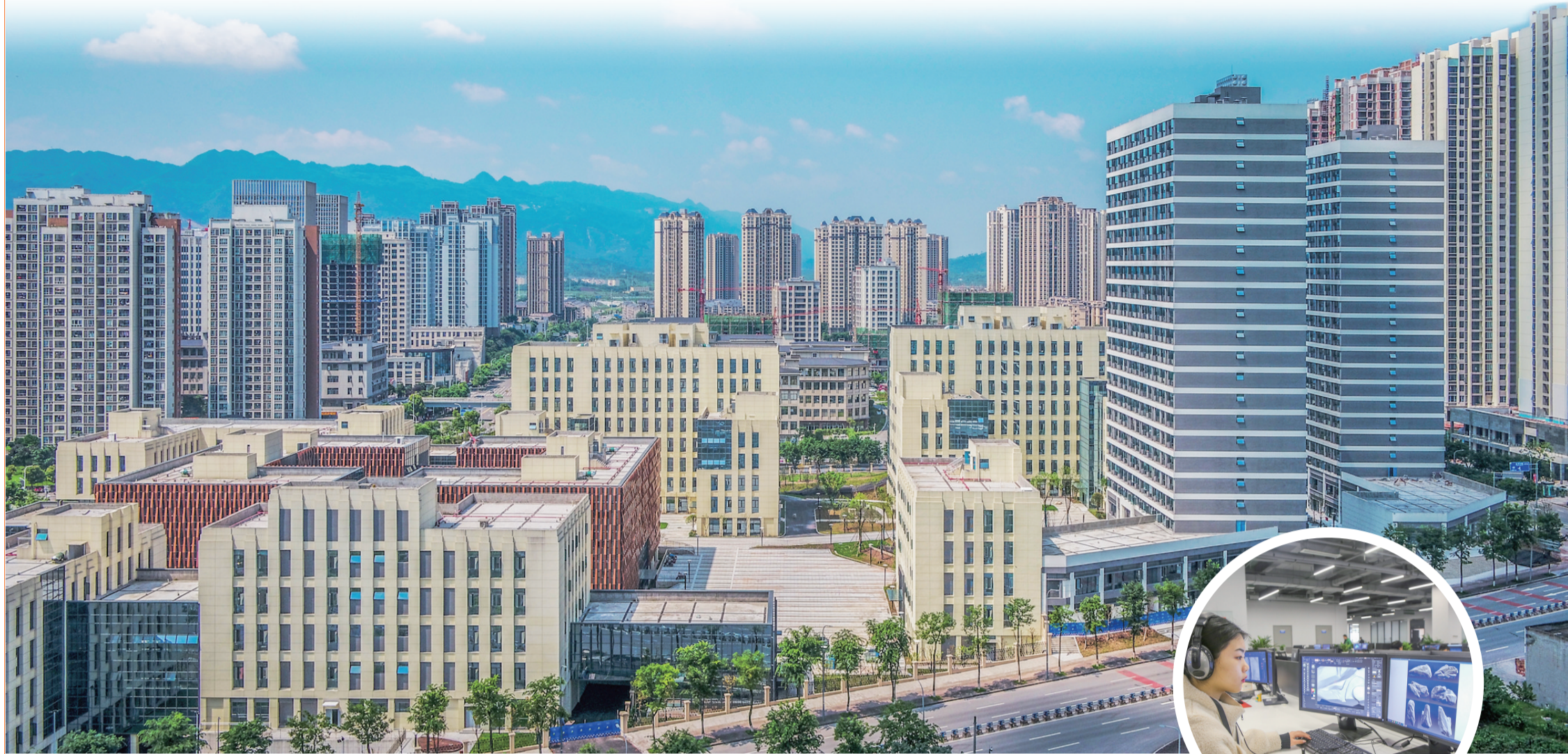
重庆云谷·永川大数据产业园
