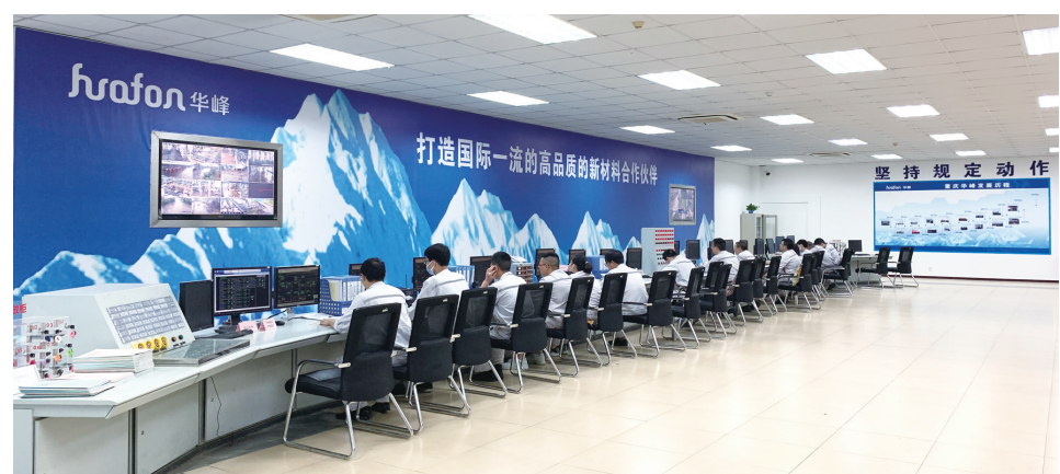
重庆华峰化工有限公司中心控制室
