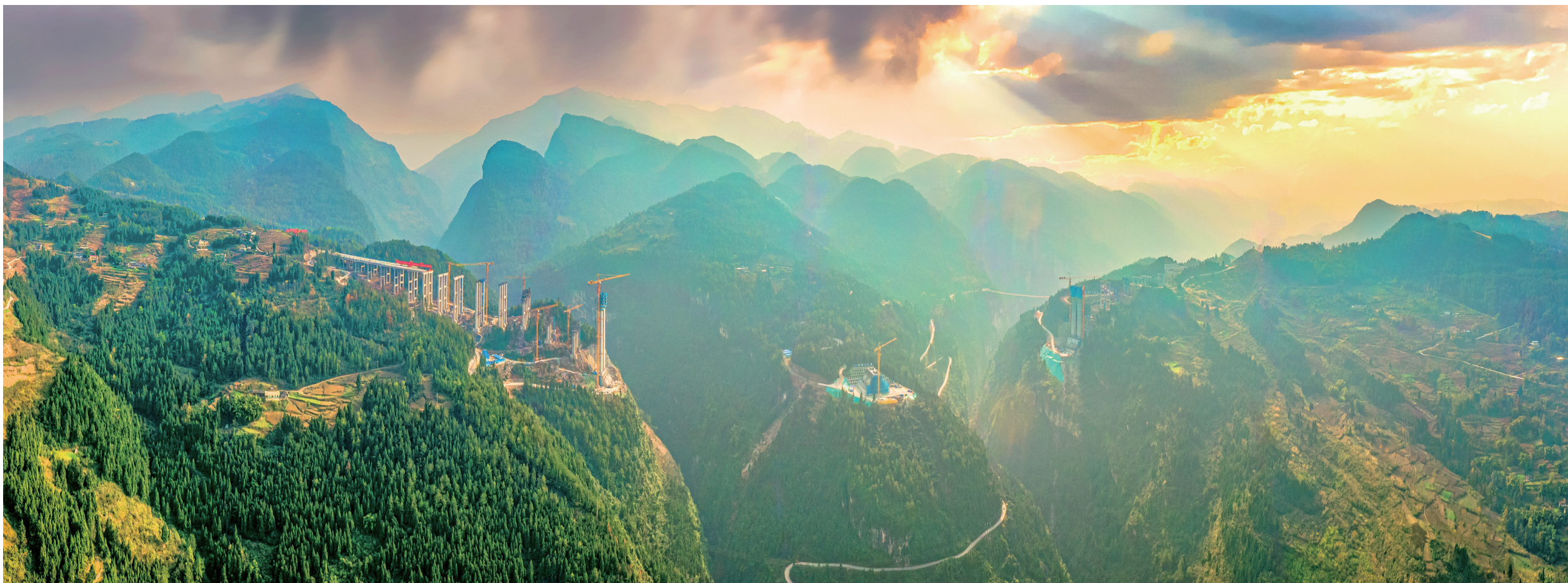
武隆巴彭路8标双堡特大桥梁
