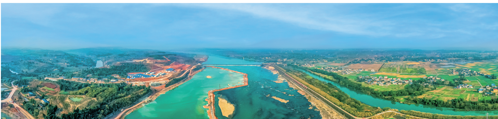
涪江双江航电枢纽工程
