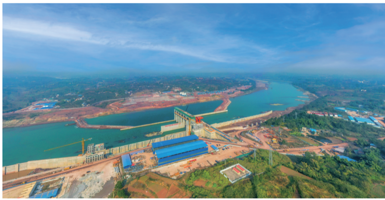
嘉陵江利泽航电枢纽工程
