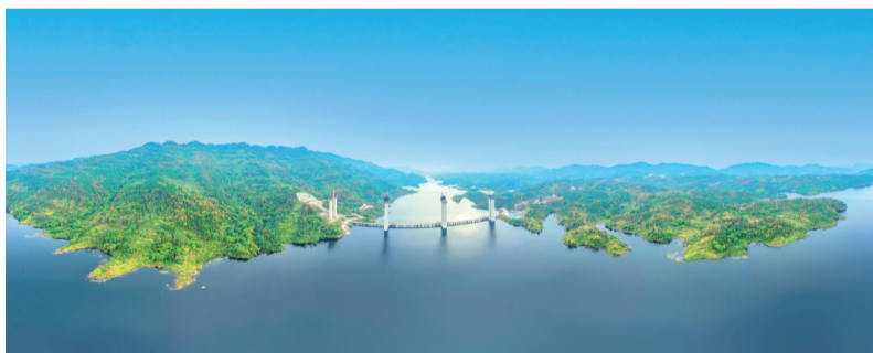
渝湘复线巴南五布河特大桥
