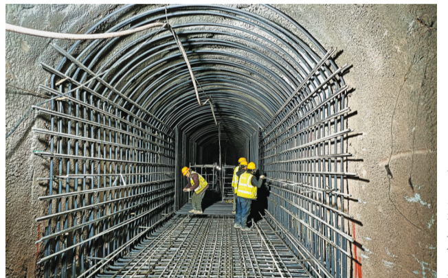
圣中水库泄洪放空洞，工人正在进行钢筋绑扎。（市水利局供图）
