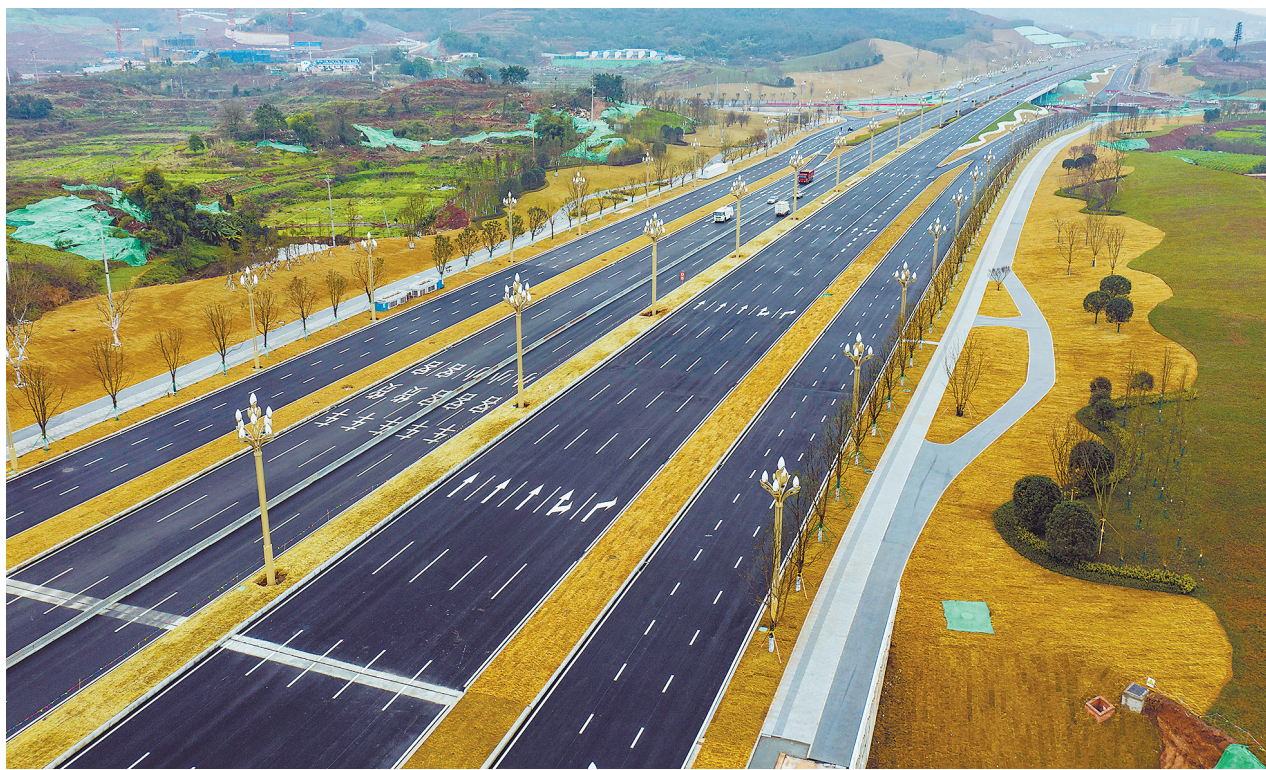
2月8日,西部(重庆)科学城科学大道一期3公里示范段正式竣工,具备通车条件。 首席记者 龙帆 摄/视觉重庆
