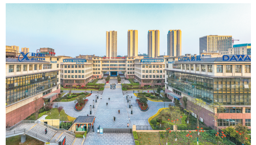
重庆云谷·永川大数据产业园
