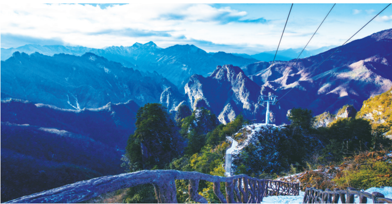
建设中的亢家寨景区
