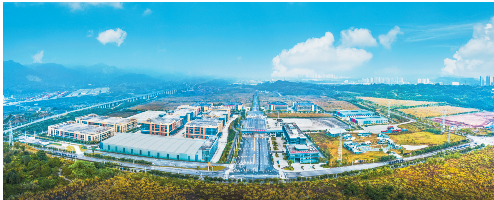
2022年1月，江津综保区(二期)基础和监管设施正式通过联合验收
